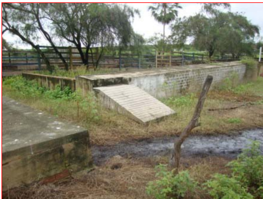
FIGURA 05 - Detalhe do afloramento do efluente do subsolo a superfície no matadouro público da cidade de Pacajus
