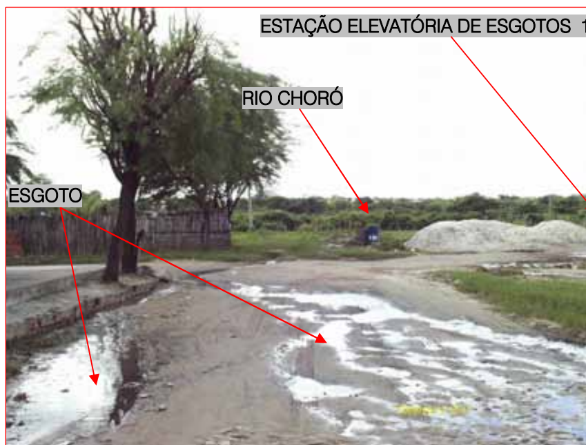
FIGURA 22 – Esgoto da cidade de Chorozinho escoando a céu aberto correndo para a calha do Rio Choró na cidade de Chorozinho
