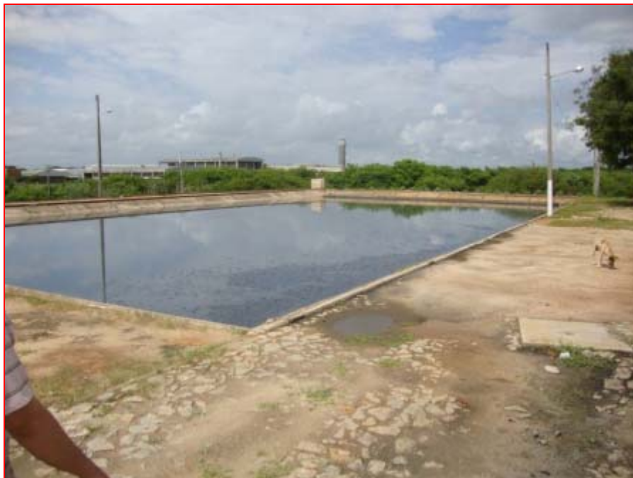
FIGURA 19 - Leitos de secagem na ETE industrial de Pacajus
