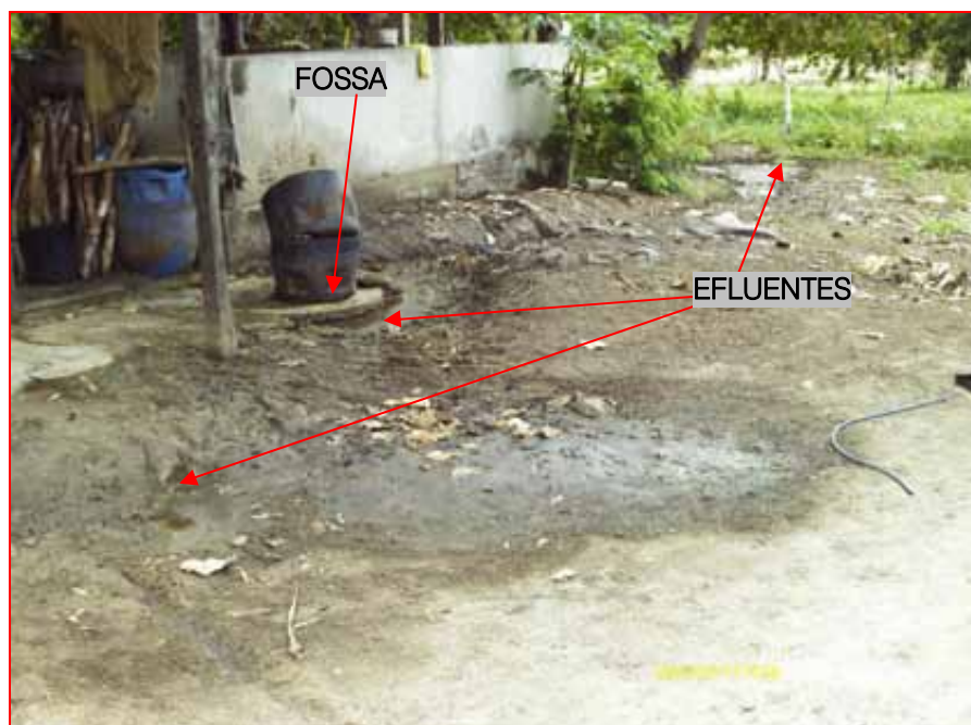
FIGURA 39 – Detalhes do escoamento de efluentes do matadouro municipal da cidade de Chorozinho.
