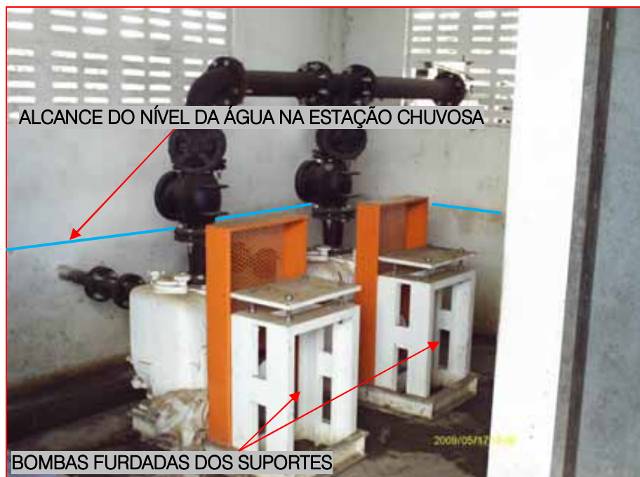
FIGURA 27 – Instalações internas da segunda estação elevatória de esgotos da cidade de Chorozinho.
