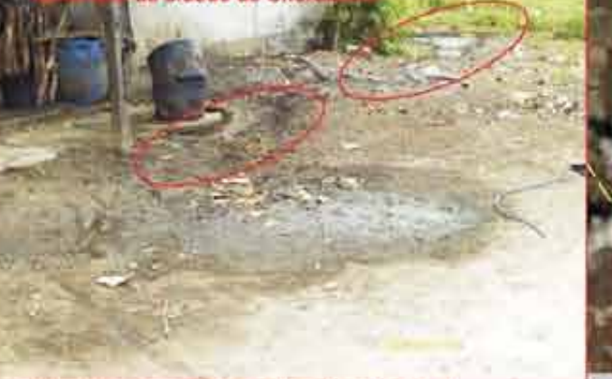
Sistema de escoamento de efluentes do matadouro municipal da cidade de Chorozinho
