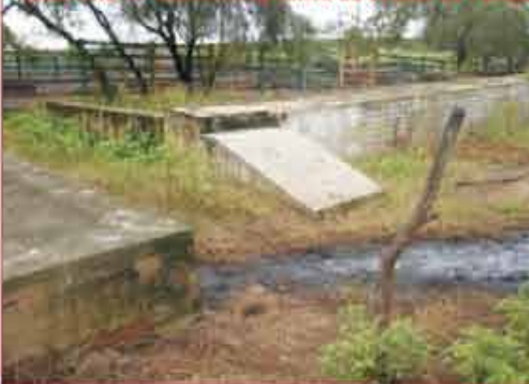
Detalhe do escoamento do efluente do abatedouro no matadouro público da cidade de Pacajus
