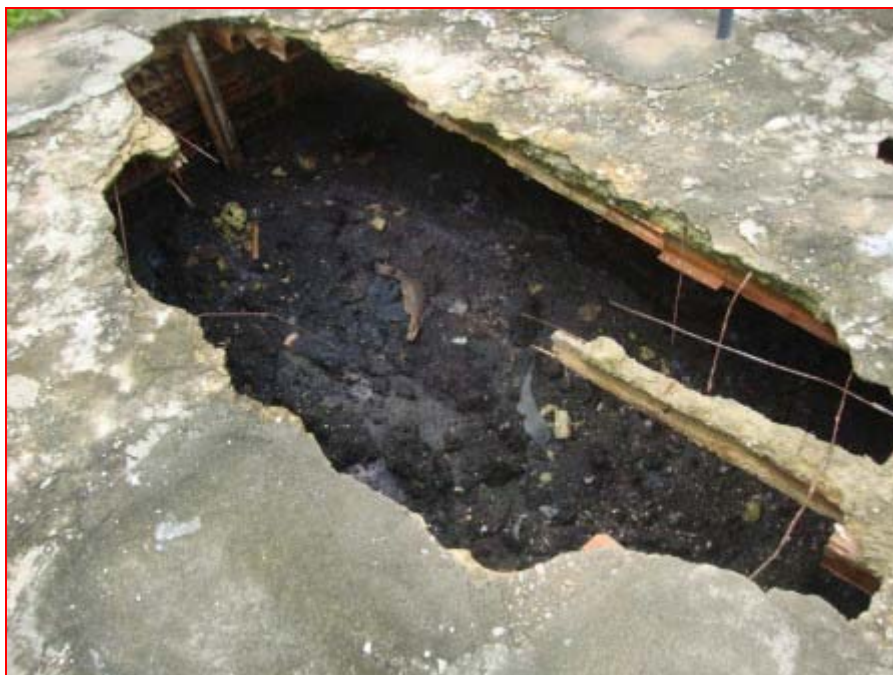
FIGURA 05 - Detalhe do afloramento do efluente do subsolo a superfície no matadouro público da cidade de Pacajus
