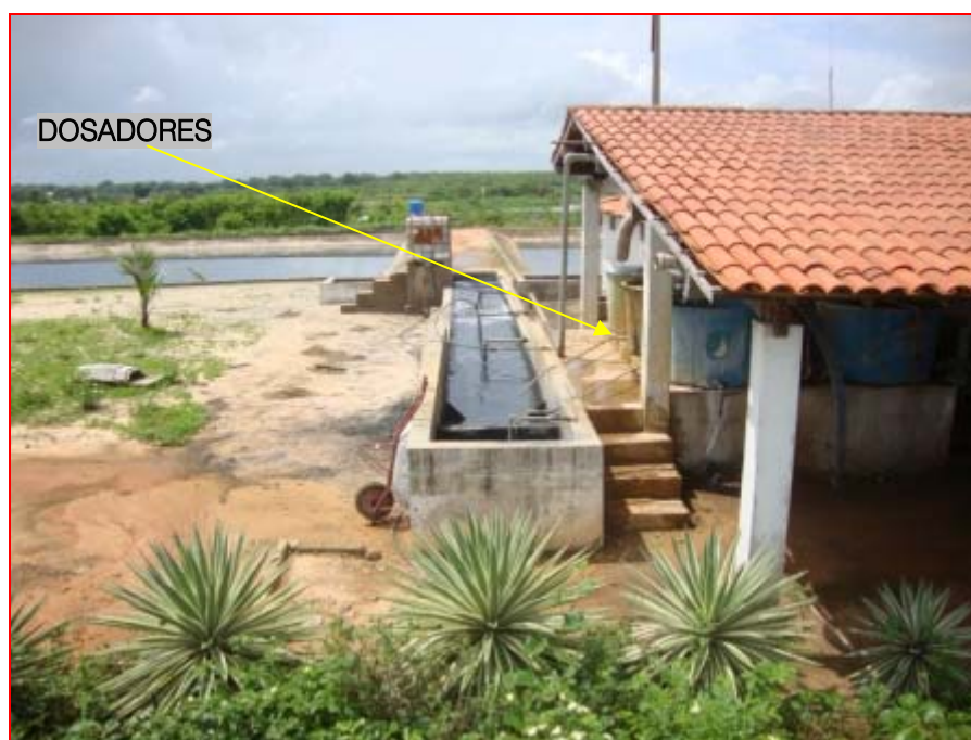
FIGURA 17 - Misturador rápido na ETE industrial de Pacajus
