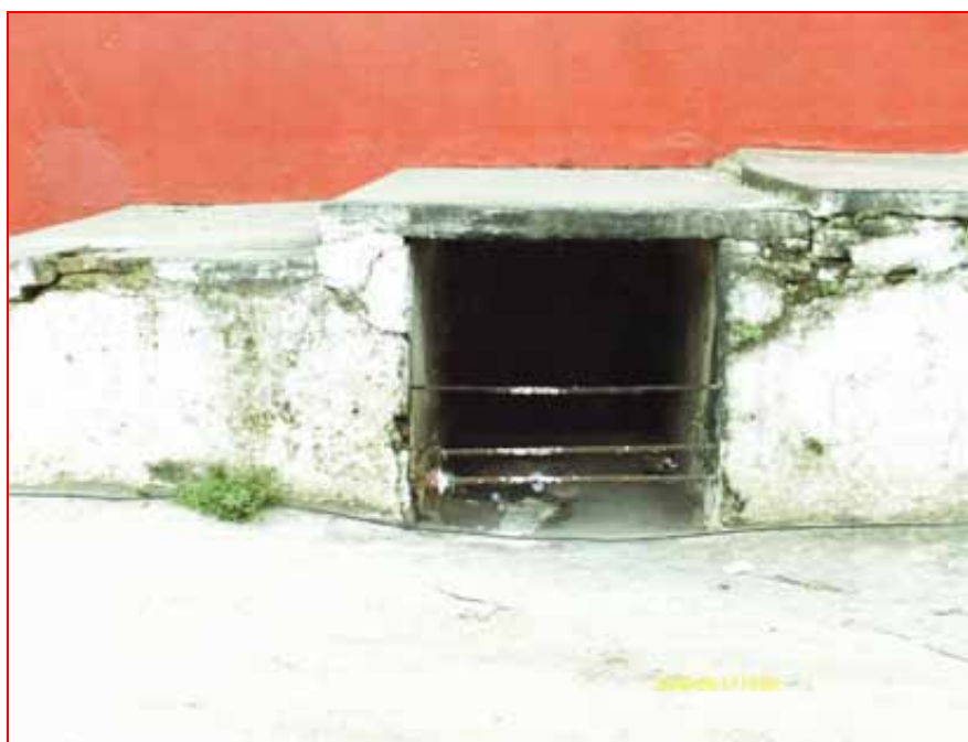
FIGURA 29 – Detalhe de galeria de drenagem na cidade de Chorozinho.
