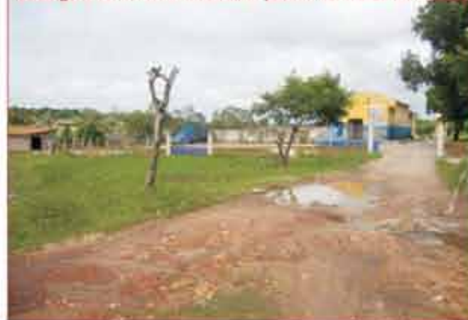
Visão geral da frente do matadouro público da cidade de Pacajus
