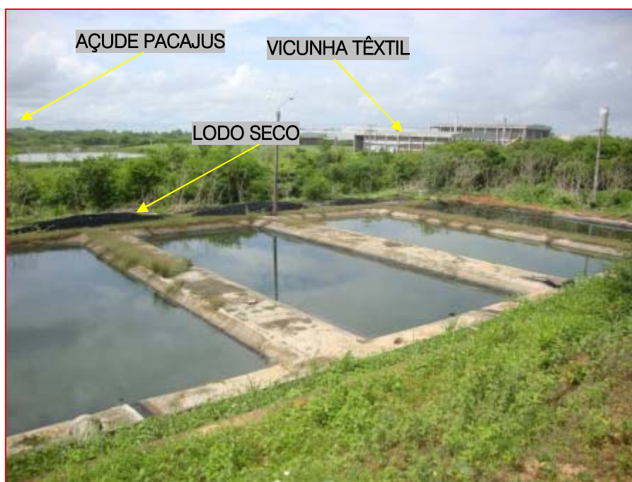
FIGURA 19 - Leitos de secagem na ETE industrial de Pacajus
