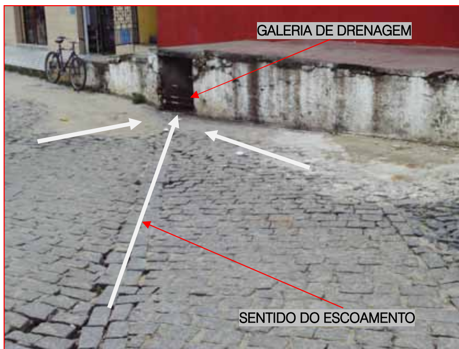
FIGURA 29 – Detalhe de galeria de drenagem na cidade de Chorozinho.
